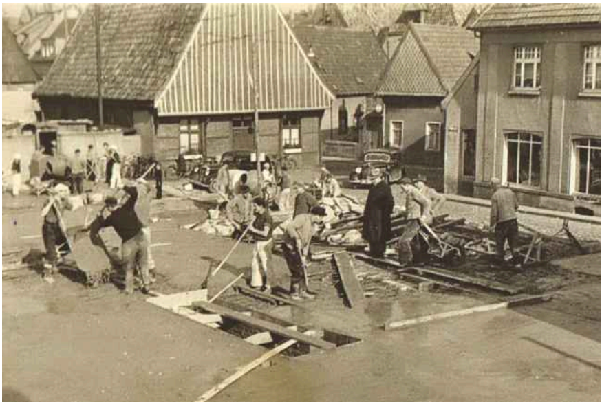
Behördenhaus, Maurerarbeiten 1953. Neustart nach dem 2. Weltkrieg: Die ausgebrannte Mädchenschule wird durch ein Behördenhaus ersetzt.
